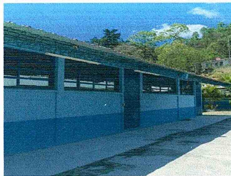
Foto 2: Ventanas instaladas en las 2 aulas de preprimaria
