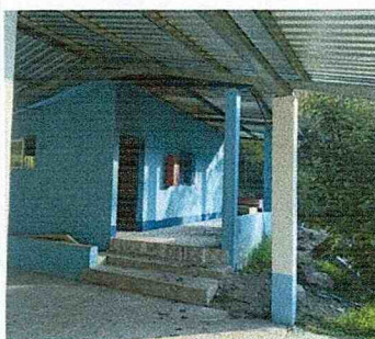
Foto 3: Mejoramiento de la cocina
