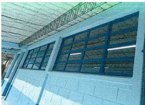
Foto1: Cambio total de ventanas
