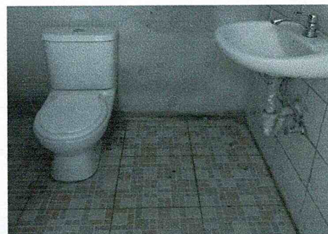
Foto 6: Mejoramiento de sanitarios
